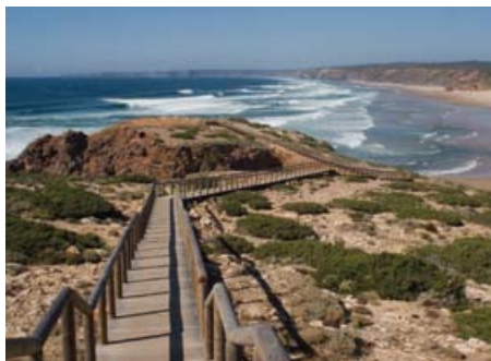
Footbridge at Pontal da Carrapateira.
